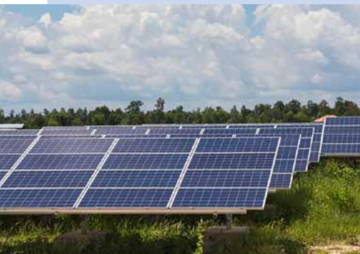
Il s'agit d'un terrain de 30 ha qui pourrait accueillir 62 900 panneaux en silicium cristallin sur structures fixes pour une puissance de 24 MWc (mégawatts-crête). La production attendue est de 27 000 MW/h par an, soit l'équivalent de la consommation d'une ville de 11 000 habitants.
